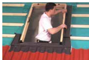
Posa degli elementi laterali del raccordo. Verificare il perfetto abbinamento degli elementi laterali al raccordo inferiore.
