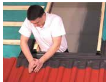
Fissaggio del raccordo inferiore: Posizionamento e fissaggio del raccordo inferiore.
