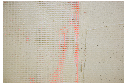
IN FASE DI POSA
