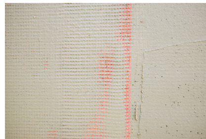
IN FASE DI POSA
