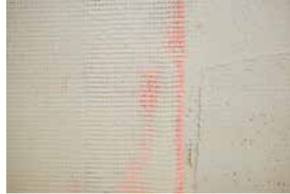
IN FASE DI POSA
