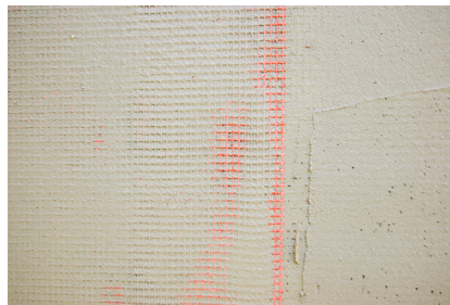
IN FASE DI POSA
